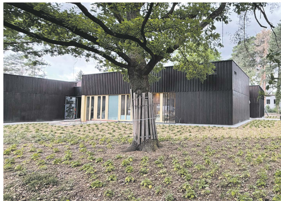
Budowa Centrum Inicjatyw Kulturalnych w Komorowie
