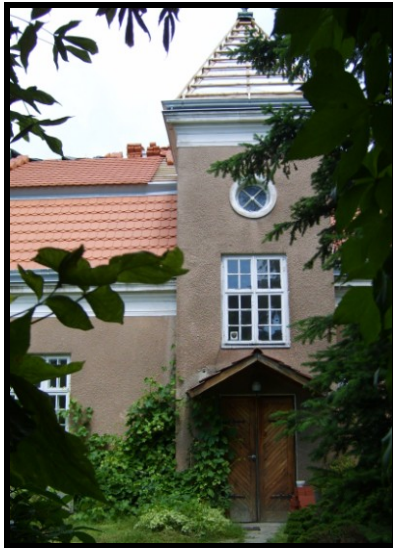
Fot.24. dom ul. Akacyjowa 12
