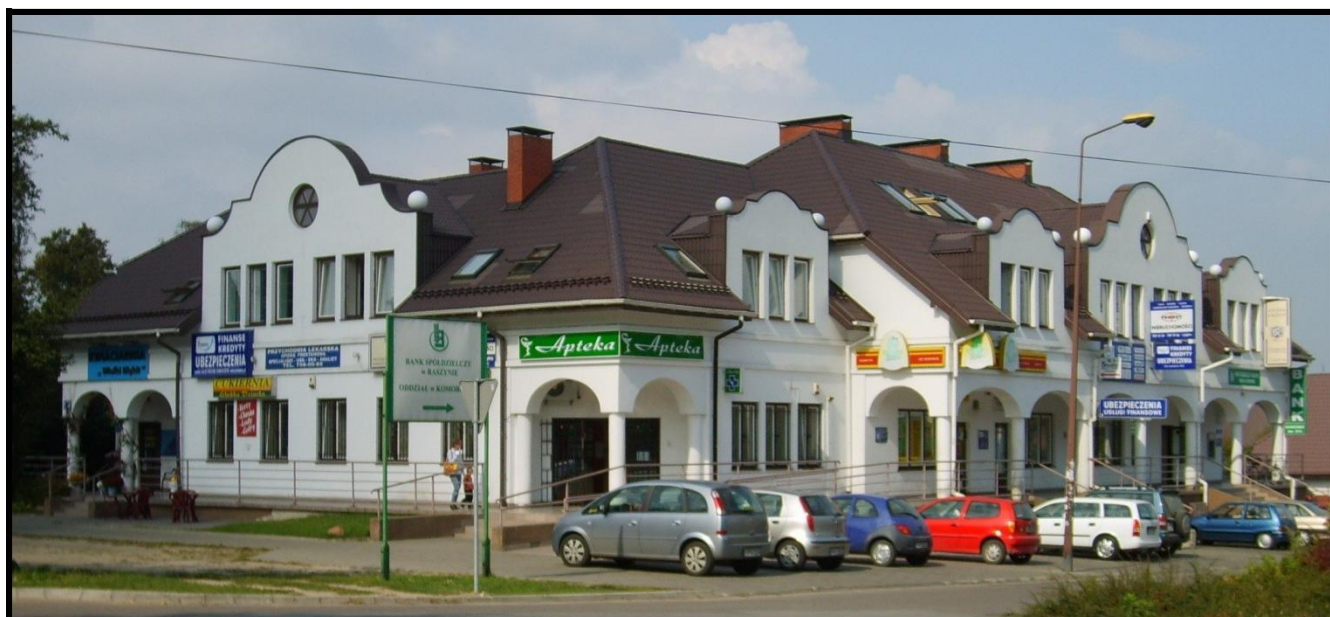
Fot.52 Nowe Centrum Komorowa
