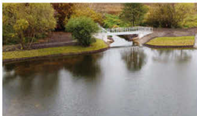
Fot. 1. Budowla wlotowa z nową kładką
