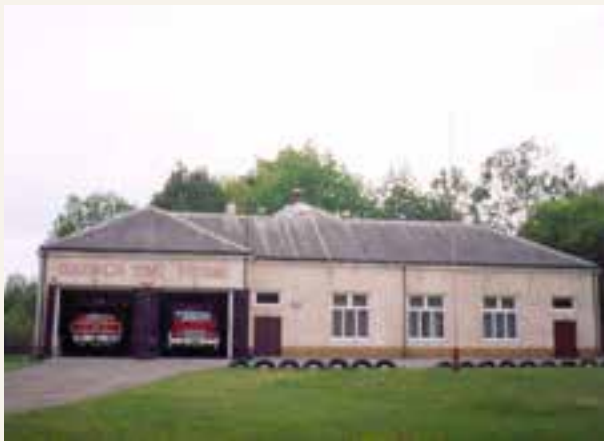
Remiza OSP przed termomodernizacją, I poł. lat 2000.
