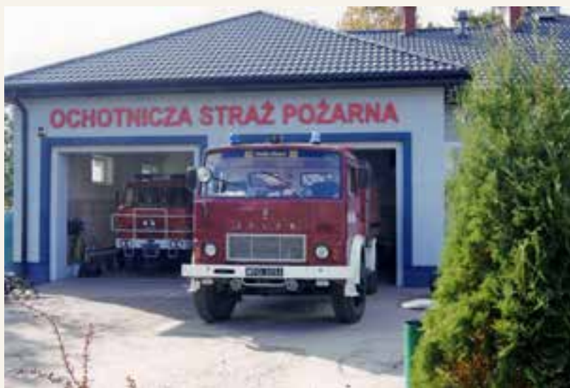
Remiza OSP po termomodernizacji, ok. 2007 r.
