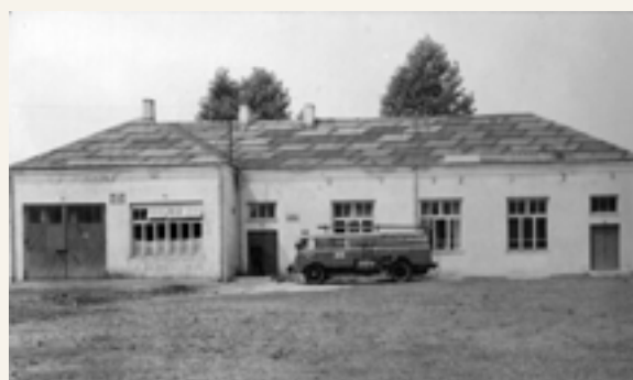
Nowa remiza na obecnym terenie OSP, 1964 r.
