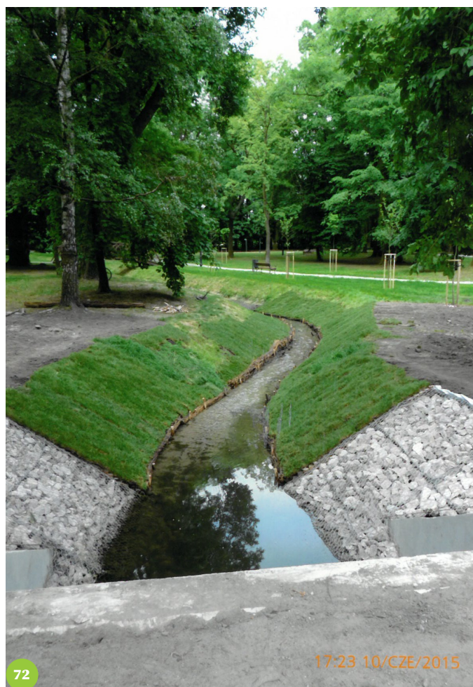
71, 72. Regulacja i obudowa faszyzną Regułki. Prace przy moście w ul. Platynowej. Obok pień starego świerku pospolitego.
