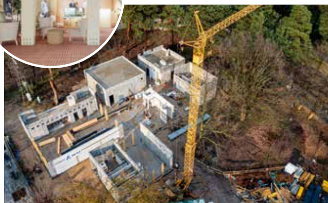
Stan budowy na 15 marca 2024 r.
