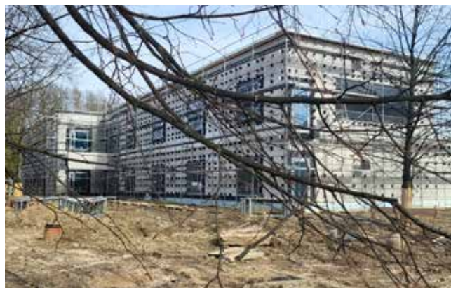
Stan budowy na 15 marca 2024 r.
