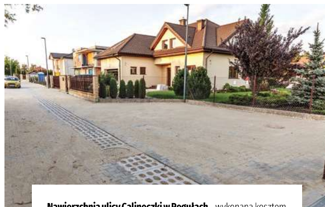
Nawierzchnia ulicy Calineczki w Regułach – wykonana kosztem 326 tys. złotych. Przetarg rozstrzygnięto w czerwcu 2019, zakończono w lipcu 2019.
