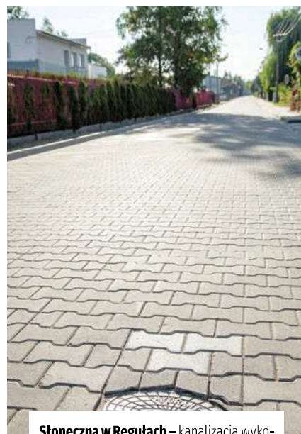
Słoneczna w Regułach – kanalizacja wykonana kosztem 600 tys. złotych, inwestycja zakończona w maju 2019.
