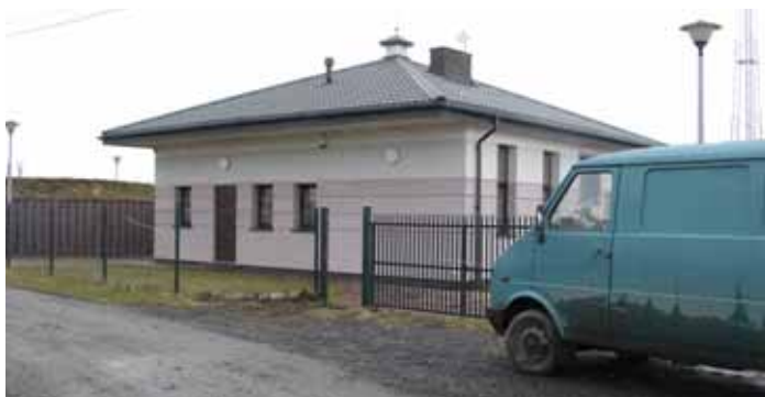
Stacja uzdatniania wody we Wsi Pęcice
