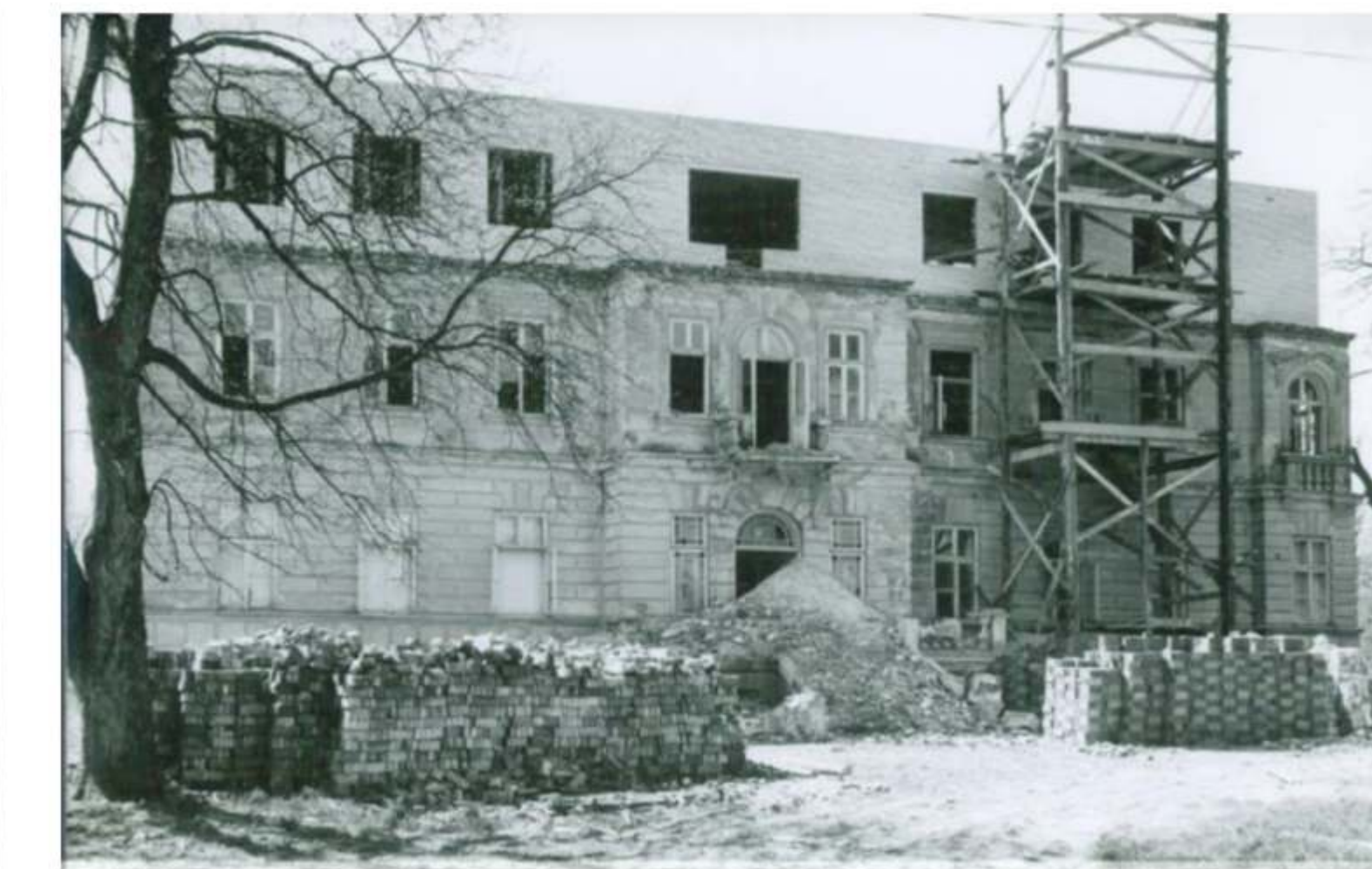
Przebudowa sanatorium w latach 50-tych zniszczyła styl pałacowy obiektu.
