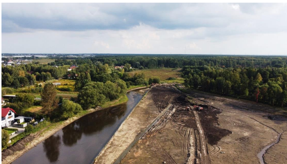
Fot. 7.5. Prace związane z przebudową zalewu w Komorowie
