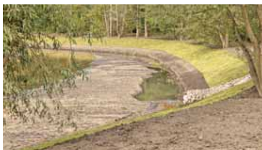
■ Zalew w trakcie modernizacji
